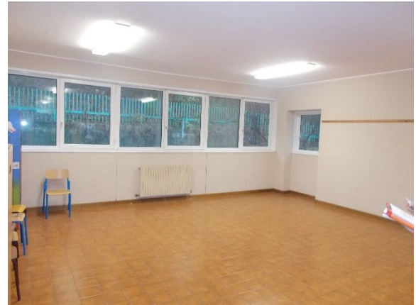
Figura 3.7 - Particolare dei serramenti
