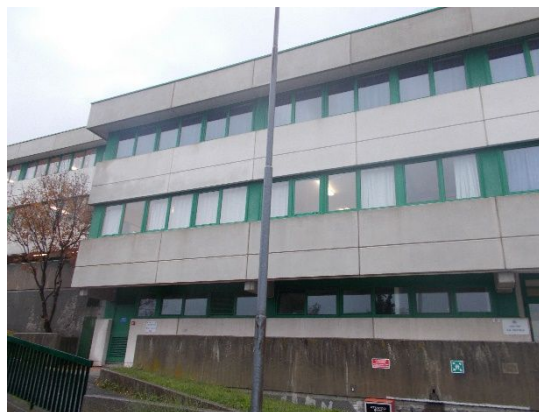
Figura 1.1 - Vista della facciata
