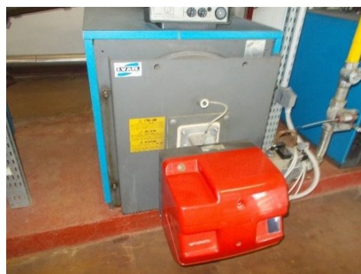
Figura 3.14 - Particolare di una caldaia tradizionale per la produzione di acqua calda sanitaria
