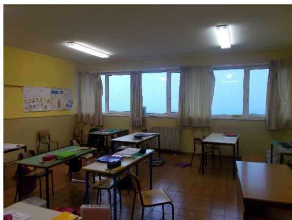
Figura 3.6 – Particolare dei radiatori
